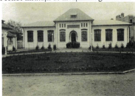
Școala, după modernizarea din 1934
